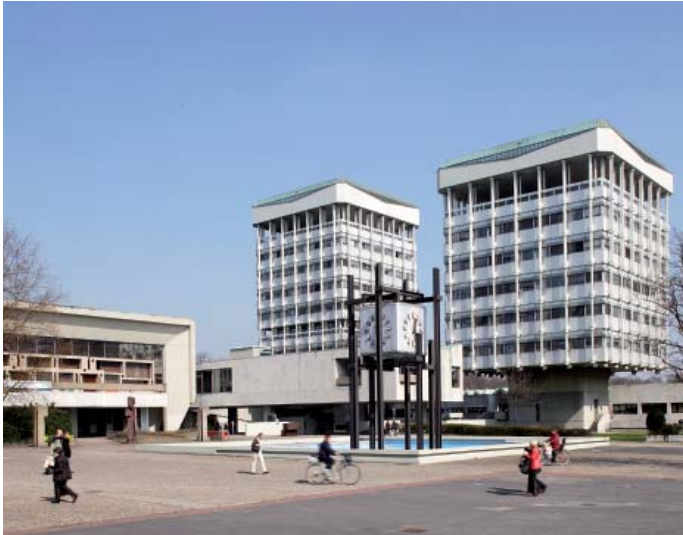
Zur Architektur der Spätmoderne forscht die Fakultät für Architektur und Bauingenieurwesen. Im Bild: die Neue Mitte Marl, erbaut in den 1960er-Jahren. [D]
