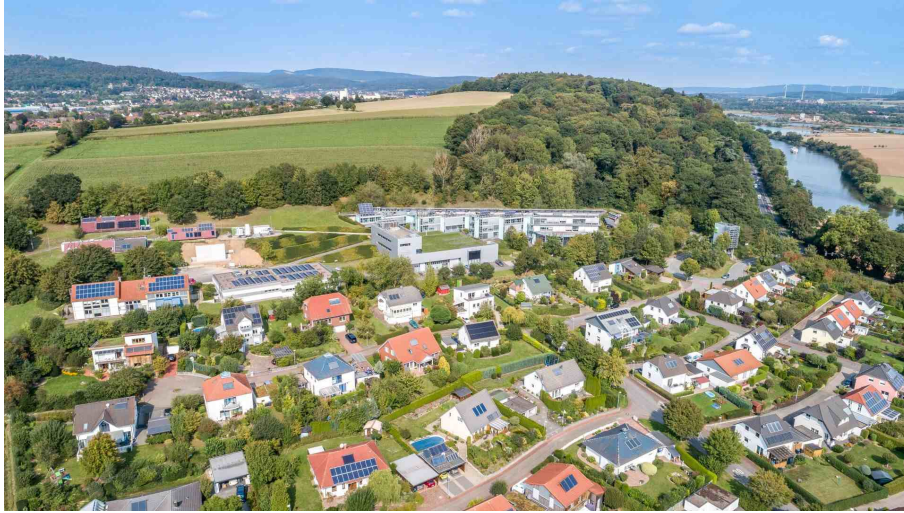
Abbildung 1: Wind-Solar-Heat Pump District am Ohrberg in der Nähe von Hameln in Niedersachsen (ISFH EnEff:Stadt Verbundvorhaben: Wind-Solar Wärmepumpen-Quartier, o.D.).
